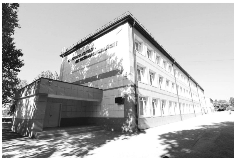
▲ Капитально отремонтированное здание СОШ № 9
