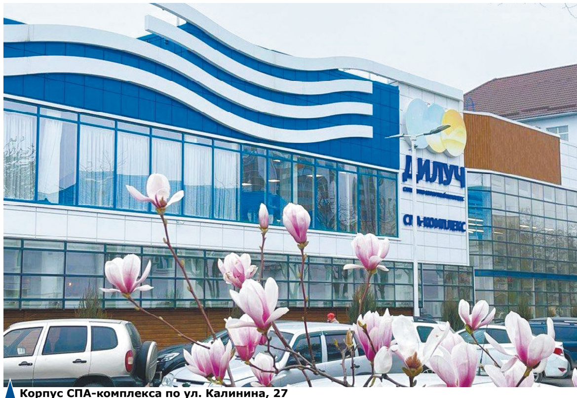
▲ Корпус СПА-комплекса по ул. Калинина, 27
