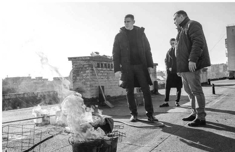
Инспекция ремонта кровли на крыше дома по улице Терской, 39
