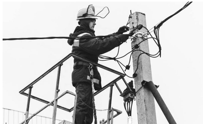
▲ Завершают работы по переключению на новую линию абонентов на улице Виноградской в Бужоре
