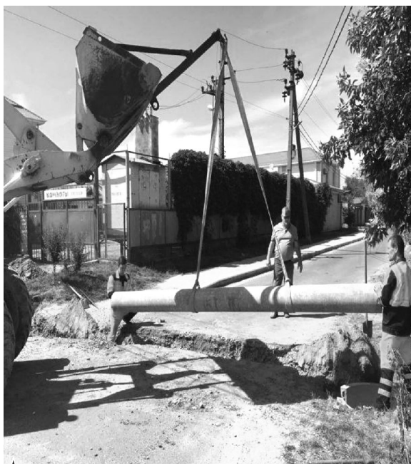
▲ Ведется прокладка водоотводящих систем
