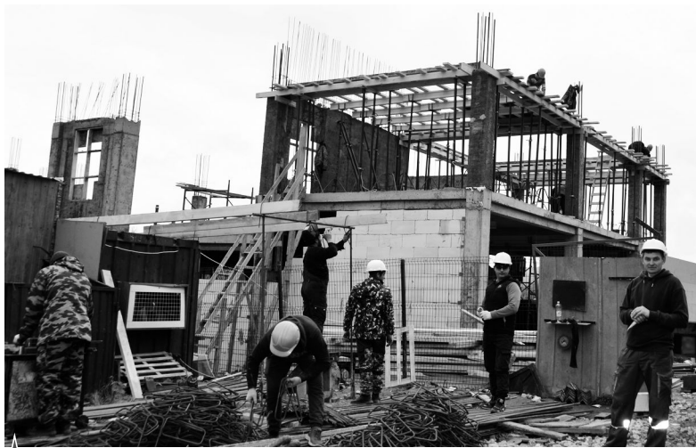
Продолжается строительство Дома культуры в селе Сукко
