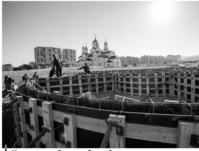
Монтаж опалубки для обустройства купели
