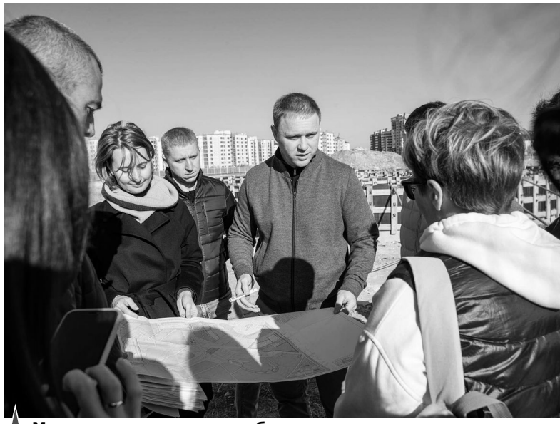
Мэр контролирует ход работ
