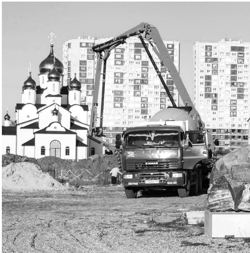
▲ Идут фундаментные работы
