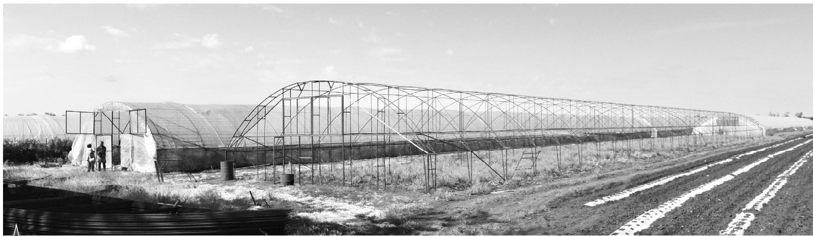
Благодаря господдержке в КФХ Роберта Цоя уже появилось шесть теплиц, а также идет строительство новых
