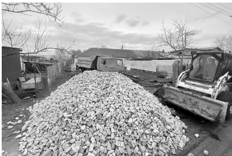
▲ Ремонт дорожного полотна в Курбацком
