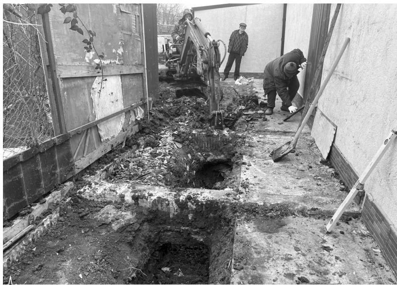
▲ Обустройство дренажной системы у клуба в Просторном
