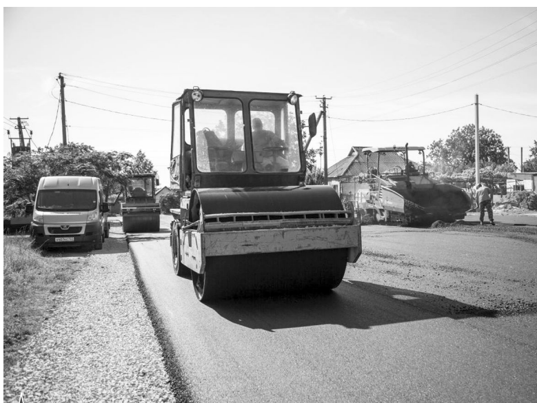
Идут ремонтные работы на городских и сельских улицах
