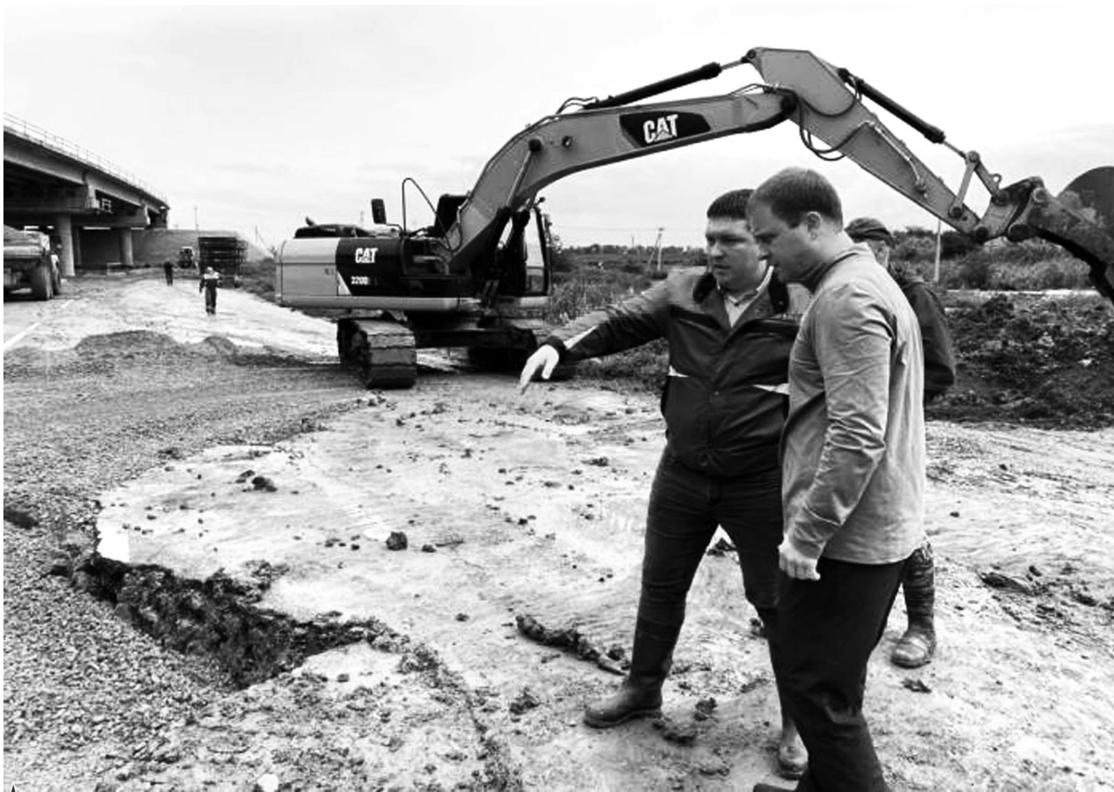
▲ Мэр Анапы Василий Шве́ц во время проведения восстановительных работ на федеральной трассе Новороссийск-Керчь
