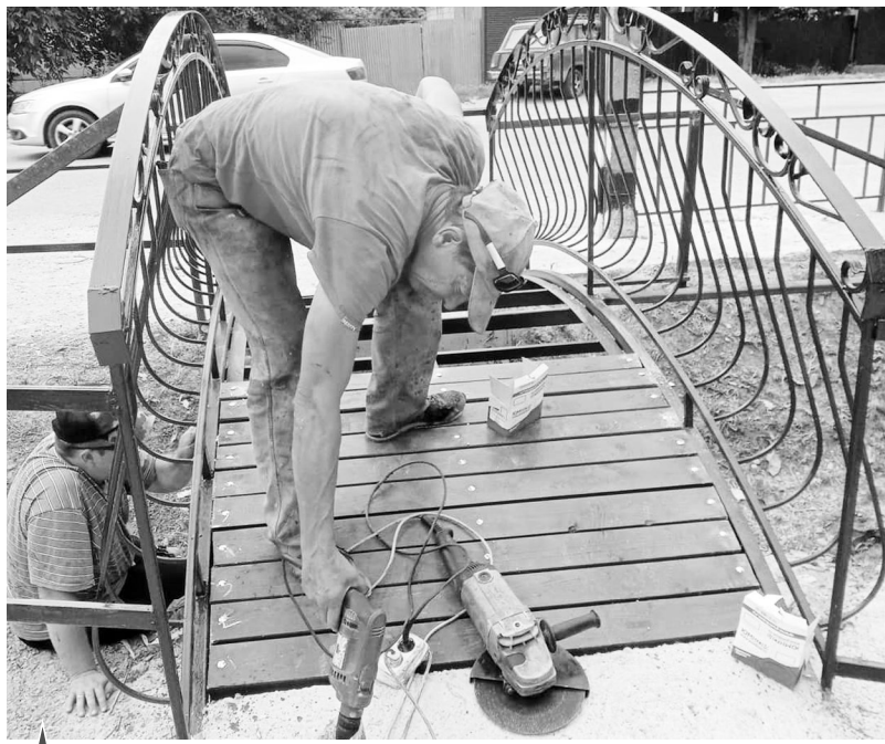
▲ На строительстве мостика
