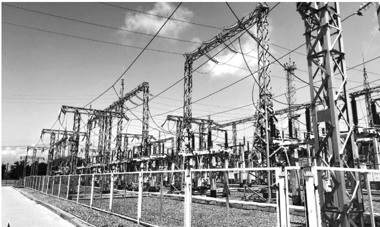
▲ В течение полугодия проведён ремонт 16 подстанций
