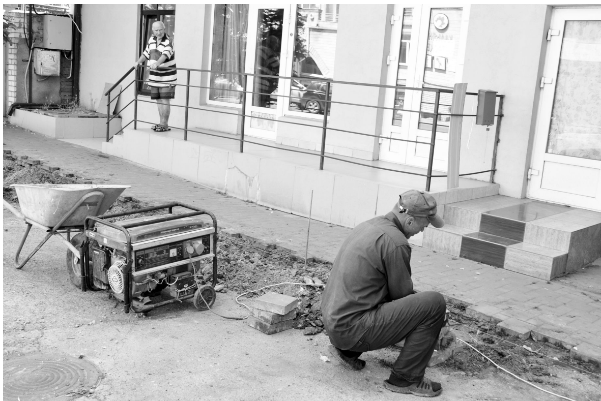
Бригада рабочих сразу приступила к ремонту тротуара
