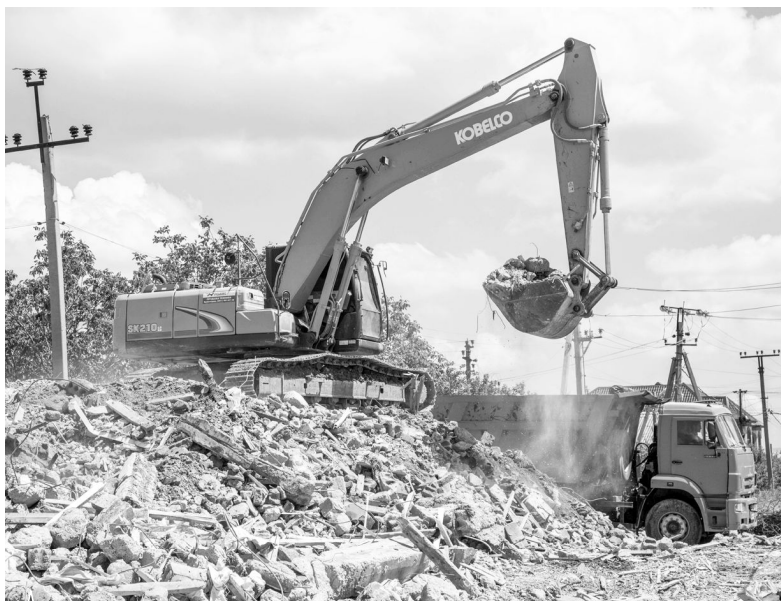
Завершение демонтажа самостроя
