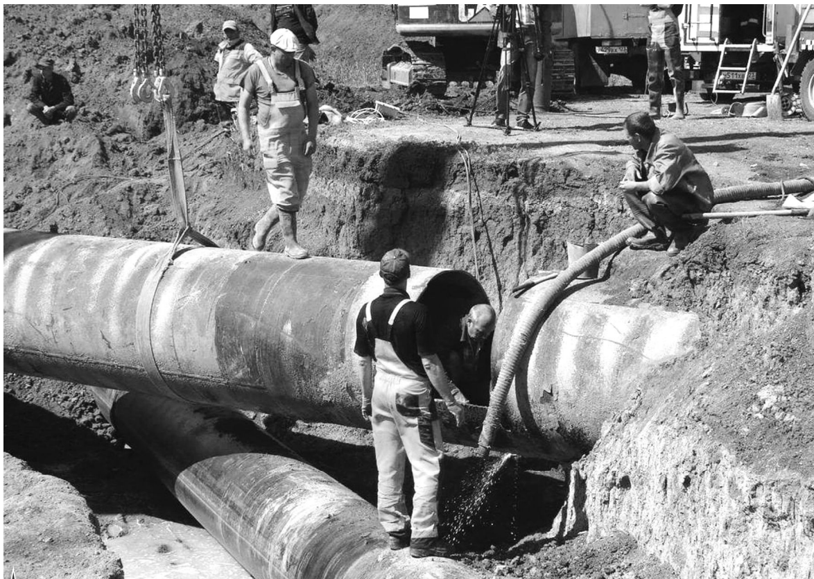
Рабочие соединяют магистральный водовод с сетью, вынесенной из зоны строительства автодороги Новороссийск-Керчь
